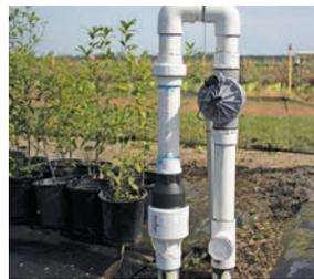
Installieren Sie den Druckregler stets stromabwärts gelegen der Sperrventile.
