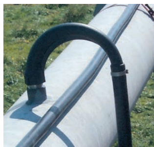
180°-Einzel-Schwanenhals mit 3/4-Zoll-Schlauchanschluss (siehe oben).
